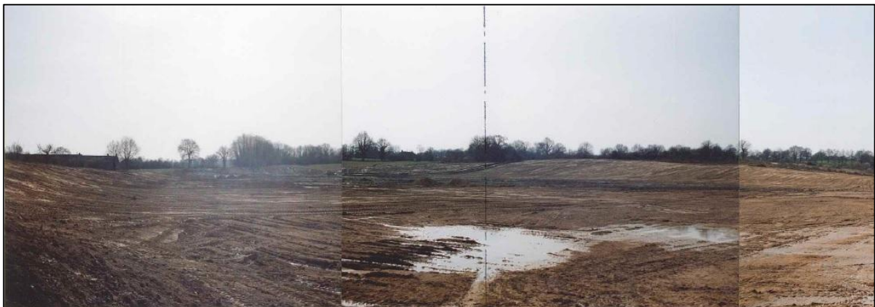
Figure 27 : MCO intégralement remblayée en mars 1992
