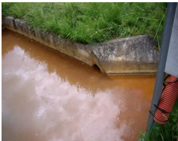
Figure 45 : bassin de répartition de 10 m 3 avec arrivée du drain de la MCO et abri du pompage des boues
