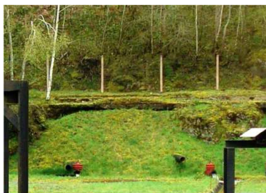
Figure 4 - Une des entrées de l'ancienne mine souterraine de Bellezane
